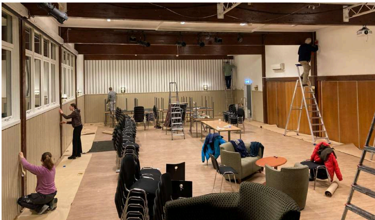
Storesalen i ferd med å pusses opp, januar 2023.
