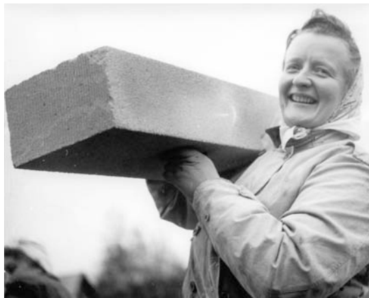
Karen Halvorsen, en av de mange husmødrene som var med i dugnadsarbeidene med å få bygd Husmorhuset i 1957/58. Her med en ytongblokk. Foto: VG. (Utlånt av Margit Tharaldsen.)
